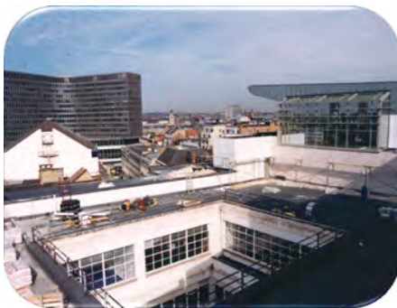
Centrala termică - faza 1
