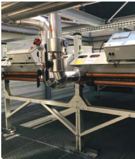
Cele 2 dry coolere (putere răcire 195 kW/buc)
